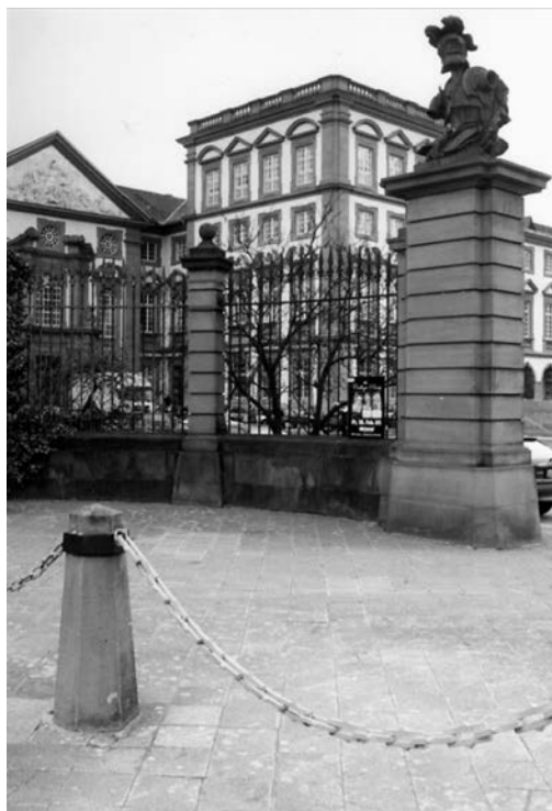
Die veränderte Eingangssituation zum Ehrenhof heute. Restaurator Hans-Volker Dursy schuf bei der Neugestaltung der Einfriedung die beiden flankierenden Trophäen nach den Vorlagen am Treppenhausepavillon. Verfasser
