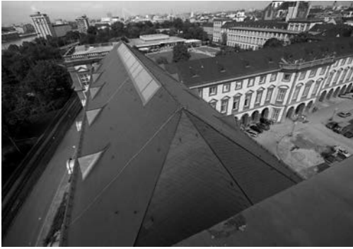
Blick auf das Mansarddach mit Oberlicht zur Rheinseite
