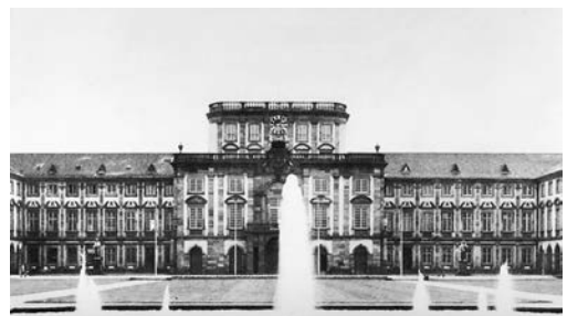
Mittelbau nach dem Wiederaufbau mit Satteldächern
