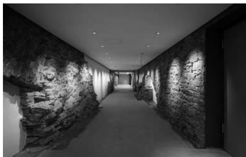
Neuer Durchgang mit Schlossfundamenten unter dem Haupttreppenhaus
