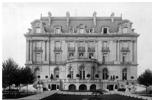
Palais Lanz, Ansicht der Gartenfassade von den Nebenbauten aus. Um 1914.
