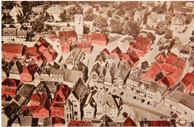
Abb. 7: Kartierung der seit 1945 beseitigten Altbauten im Zentrum der Altstadt auf einem Luftbild von 1953. Bei Gebäuden mit »?« ist unklar, ob im heutigen Gebäude noch Reste des Altbaus vorhanden sind (Foto: Blum: Archivbilder Bretten. 2007, S. 19; Kartierung: Christopher Retsch)
