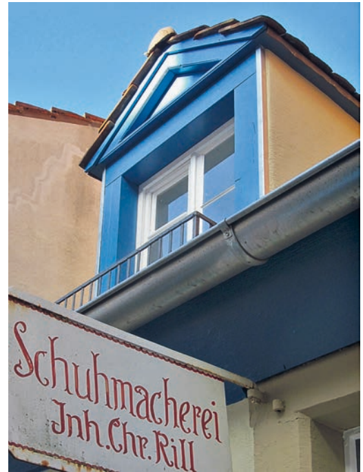
Die neue, dem historischen Vorbild originalgetreu nachgestaltete Dachgaube (Foto: Max Trinter)
