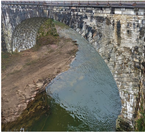
2016 – Bahnbrücke, Zustand vor dem Abbruch (Foto: Stephan Späth)
