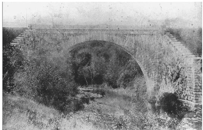
1856 – Bahnbrücke über die Alb nach ihrer Fertigstellung (Foto privat)
