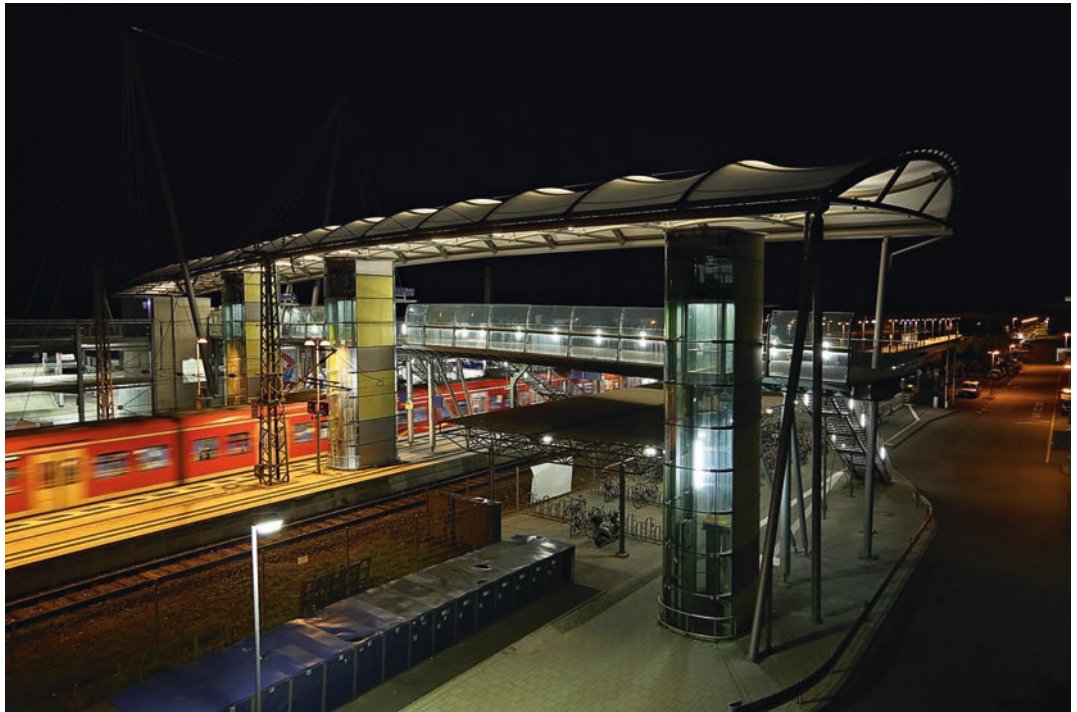
Bahnhof Wiesloch-Walldorf. Die Schnittstelle des Doppelzentrums (Foto: Helmut Pfeifer)
