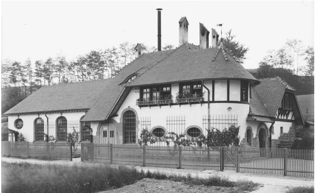
Pumphaus im Maisbachtal, Aufnahme von Wilhelm Kratt 1910 (Landesamt für Denkmalpflege, Dienststz Karlsruhe)
