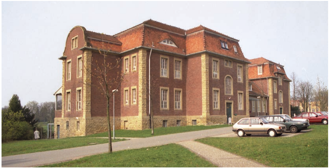
Krankengebäude für männliche Epileptiker ME, Aufnahme 2007 (PZN)
