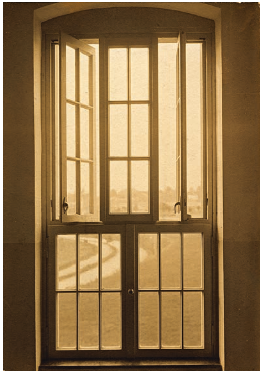
Das »Wieslocher Fenster« mit fixierten Flügeln unterhalb und drehbaren Flügeln oberhalb des Kämpfers. Aufnahme vor 1910 (PZN)
