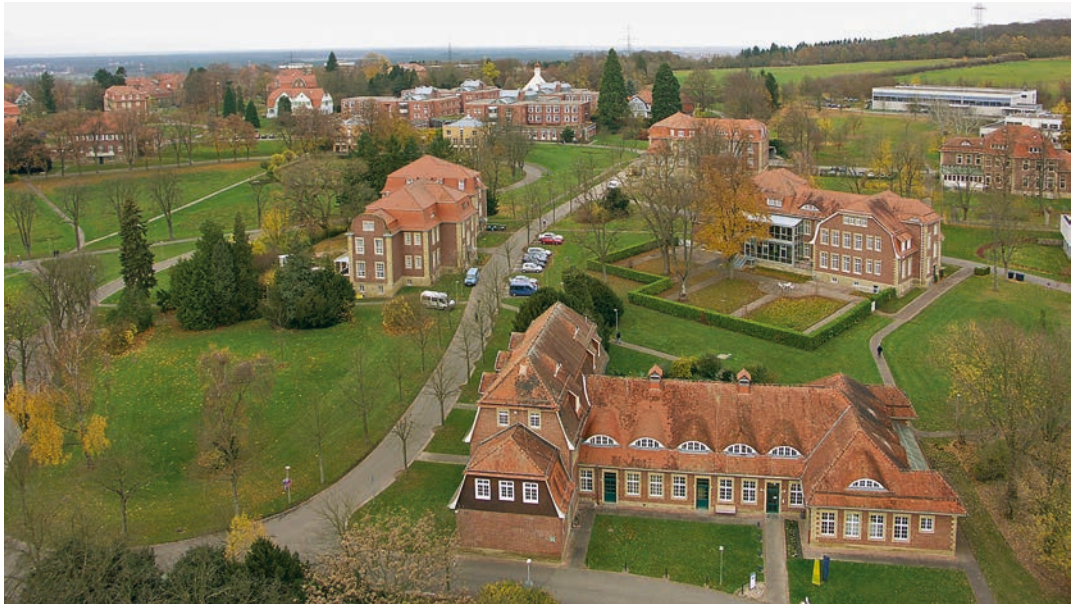
Krankengebäude für männliche Epileptiker ME und halbruhige Männer MH1, vorn das Werkstättengebäude, Aufnahme 2008 (PZN)
