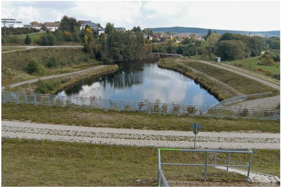
Kolksee auf der Landseite des Dammes (alle Fotos: Otto E. Hofmann)
