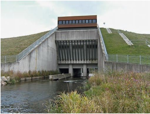
Betriebsgebäude, Rechen der Hochwasserentlastung, Auslassbauwerk
