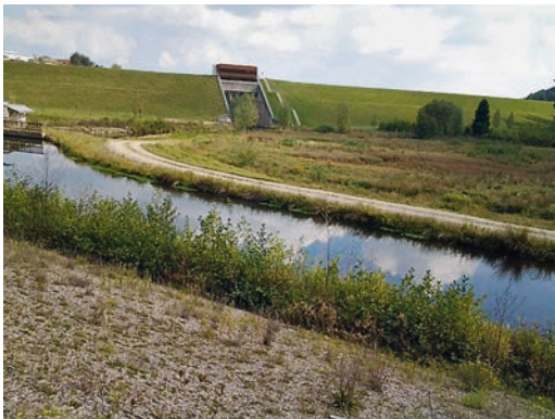
Damm von der »Seeseite« aus, rechts Feuchtwiesen
