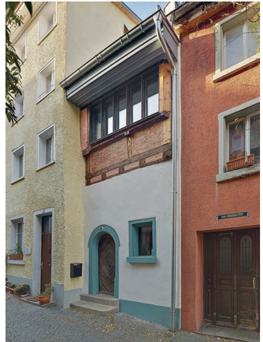
Nur gut drei Meter breit ist das bis ins Mittelalter zurückgehende Haus in der Konstanzer Altstadtgasse. Im Obergeschoss sieht man das freigelegte Fachwerk und den nach Befund wiederhergestellten Fenstererker. © Guido Kasper
