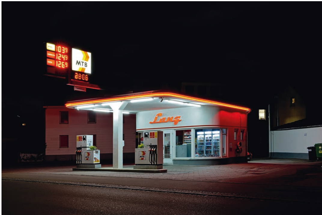
Dank der wiederhergestellten Beleuchtung am Flachdachrand bietet die Tankstelle auch bei Nacht ein eindrückliches Bild. © Preisträger
