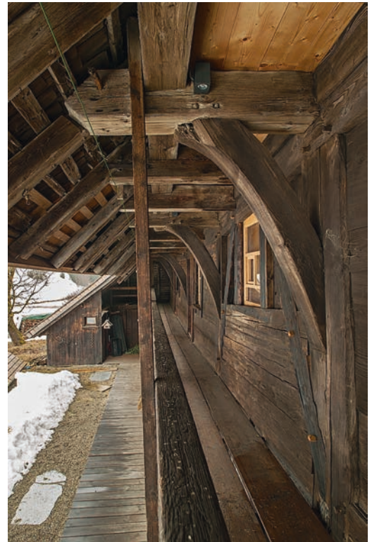
Unter dem weit vorkragenden Dach hat sich die alte hölzerne Außenwand über die Jahrhunderte unverändert erhalten. © Bernd Hausner
