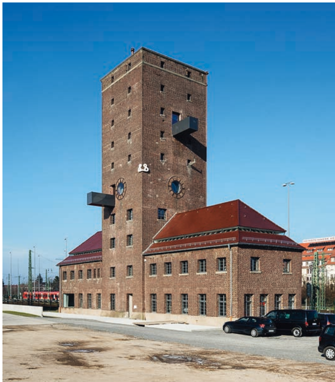
Ein eindrucksvolles Beispiel für die sachliche Monumentalität von Funktionsgebäuden der 1920er-Jahre: der ehemalige Bahnwasserturm in Heidelberg nach seiner Sanierung und Umnutzung.
