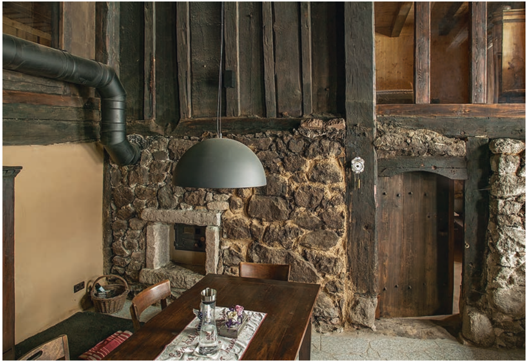
Die von ihrer eingezogenen Zwischendecke befreite Rauchküche mit roher Steinmauer und Durchgang zum Vorratsraum. © Bernd Hausner
