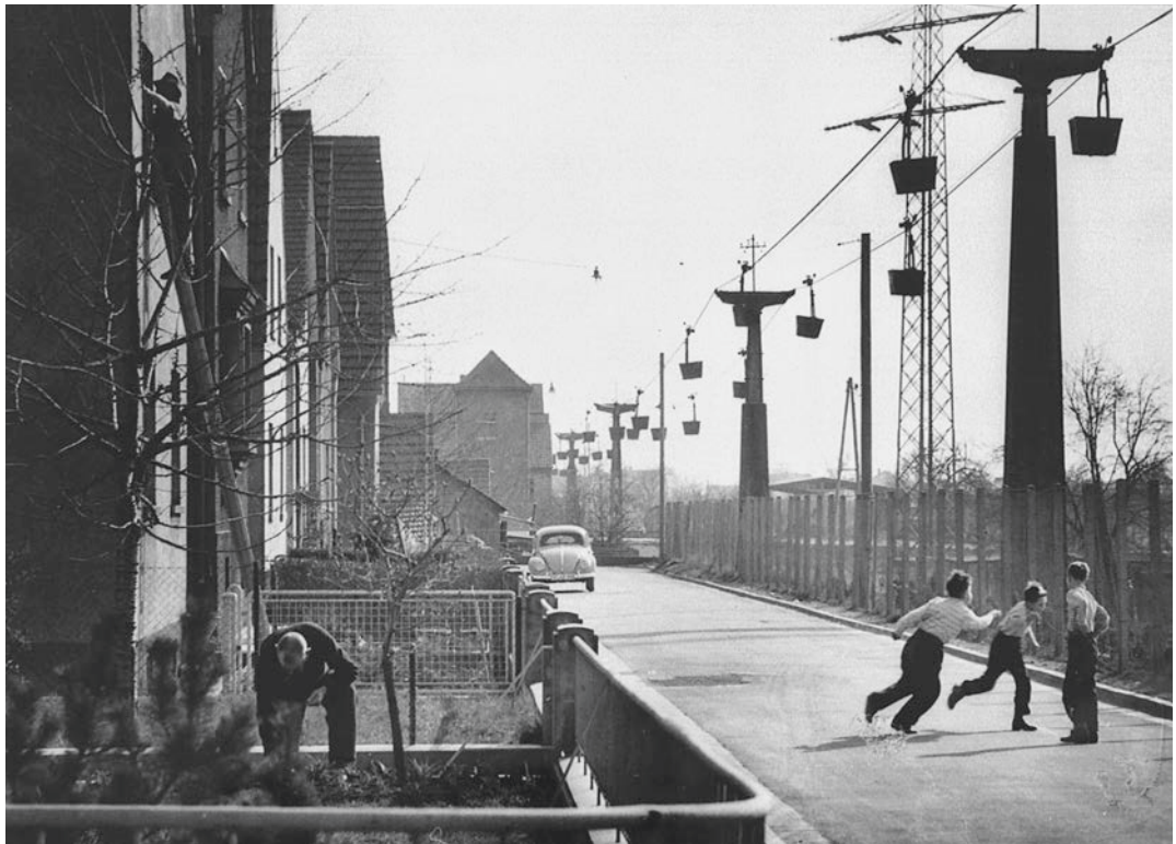
Abb. 9: Die Seilbahn an der Zementwerkstraße in Leimen
