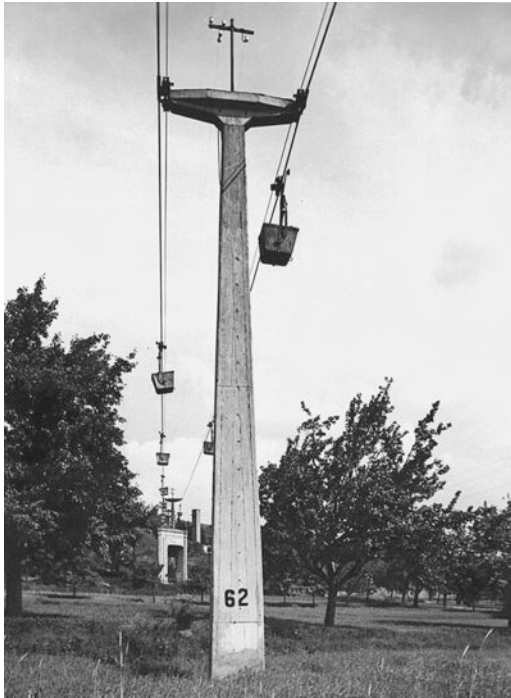
Abb. 10: Seilbahnstützen mit Hängeloren zwischen Nußloch und Leimen (1951)
