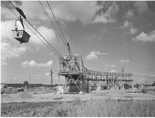
Abb. 11: Die neue Seilbahn mit den größeren Loren und die Kurvenstation (1964)
