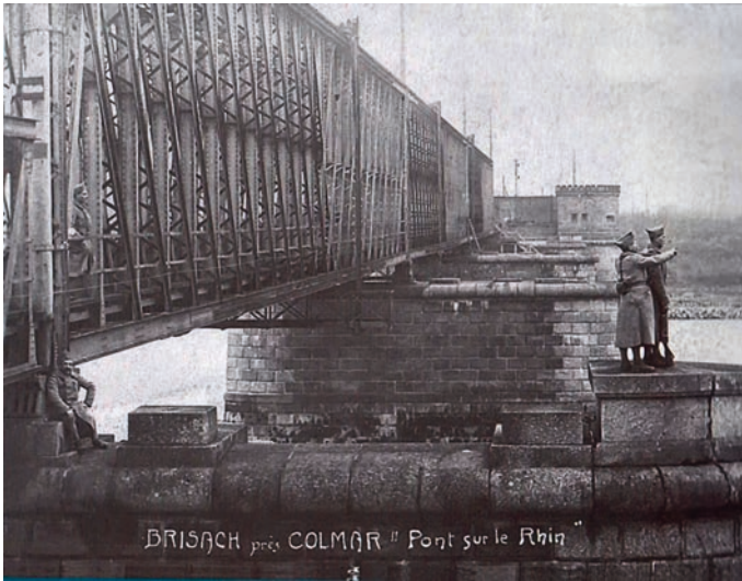
Die Rheinbrücke Breisach-Colmar vor dem Zweiten Weltkrieg (Archiv TRR)
