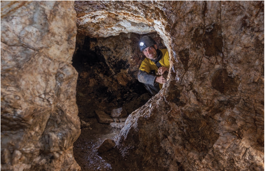
Querschlag im St.-Josephi-Stollen mit etwa 80 Zentimeter Höhe (Foto M. Eckmann)
