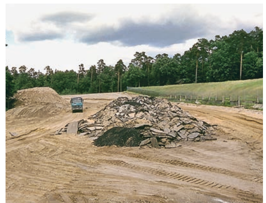
Umbauarbeiten an der Strecke
