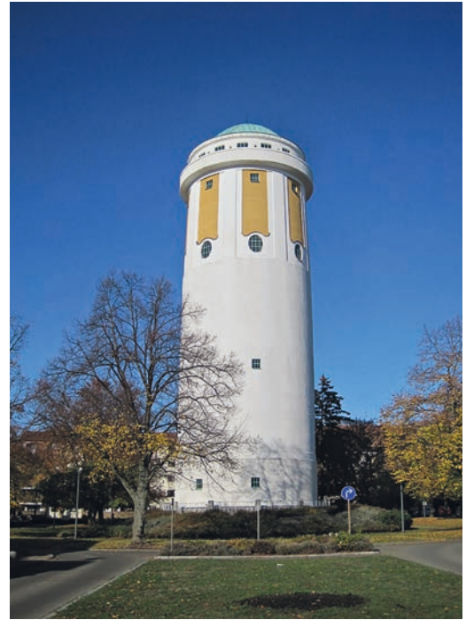
Der Wasserturm (Alle Fotos: Alfred Rupp)
