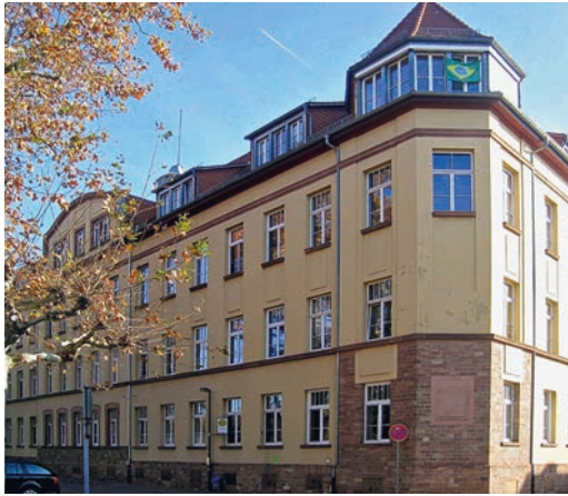
Außenfassade der GEG-Zigarrenfabrik
