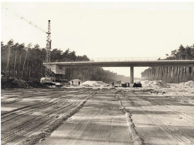
Bau der Autobahn A6 und Einhebung der Contibrücke im Jahr 1964 (Bild: Stadt Hockenheim)
