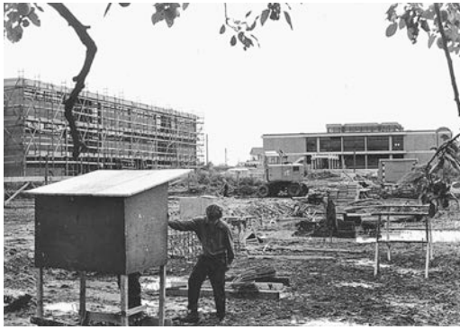
Das Schulzentrum entsteht (Bild: Stadt Hockenheim)
