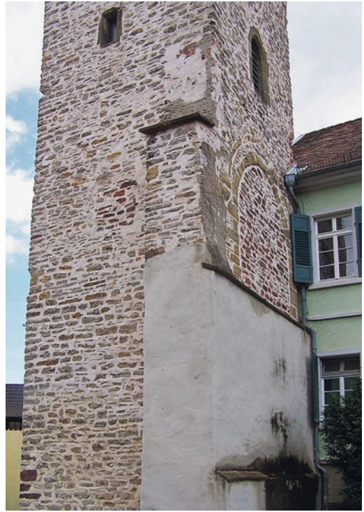
Wiesloch: Spätmittelalterlicher Lug-ins-Land der Burg; im mittleren Bereich der zugemauerte Triumphbogen der einstigen Kapelle; das Mauerwerk darunter aus klein- formatigen Steinen könnte noch von der ursprünglichen Burg stammen. (Foto: Nicolai Knauer)
