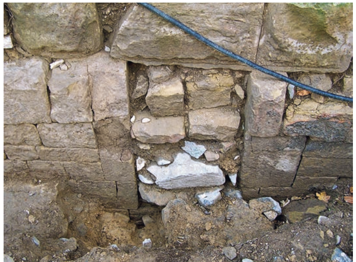
Steinsberg: Ringmauer der Bauphase 1 um 1100 mit Pforte und vorgelagertem Sockel (Foto: Nicolai Knauer)
