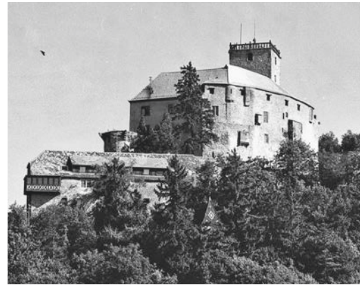
Burg Guttenberg bei Neckarmühlbach. Das Foto stammt aus den 1980er-Jahren und zeigt die nie zerstörte und bis heute bewohnte mittelalterliche Wehranlage von Nordwesten (KA MOS J 18/600).
