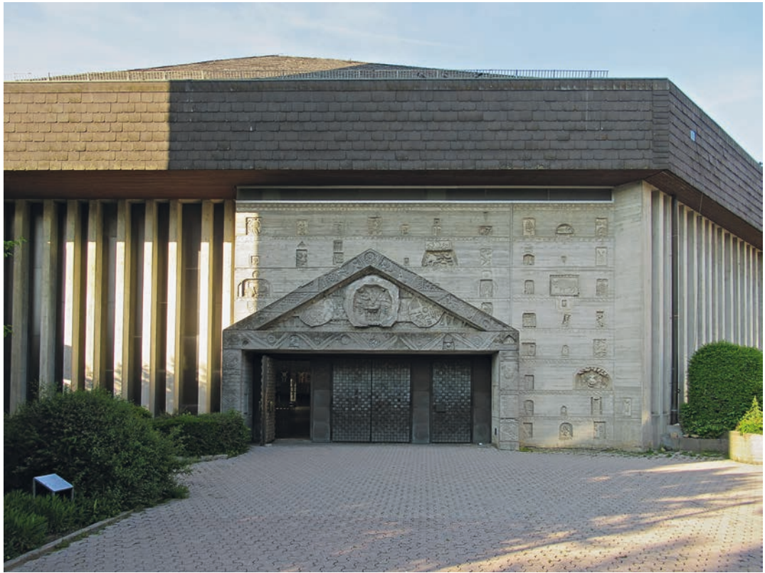
Hauptportal der St. Kilianskirche Osterburken, errichtet 1970–1974. Die Betonreliefs an der Fassade und im Innern der Kirche stammen von Emil Wachter
