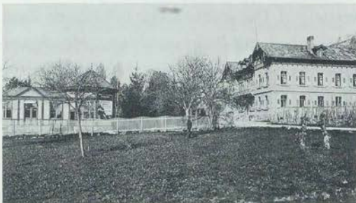
Abb. 6a: Die »Emilienbad-Kuranstalt Grenzach«, so unterschrieb der Baseler Fotograf Emil Birkhäuser dieses um 1890 entstandene Foto mit dem Kurhaus, dem Quellenhaus und angebauter Trinkhalle. Lediglich das Quellenhaus hat die Zeit überdauert; alle anderen Gebäude sind längst dem Erdboden gleichgemacht.
