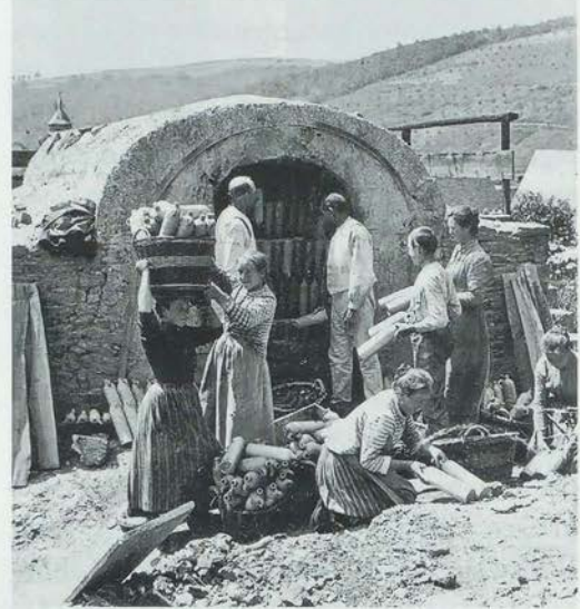
Abb. 5b: Einsetzen der weißtrockenen Mineralwasserkrüge in den Krugofen, den sie nach dem Brand hellgelb bis rotbraun gefärbt (Abb. 4 und 4a) wieder verließen, um 1900.
