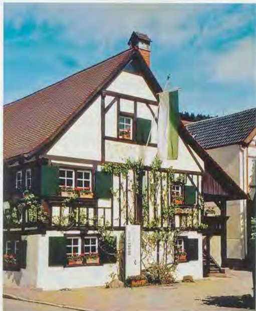
Das renovierte und erweiterte Hebelhaus in Hausen im Wiesental (Landkreis Lörrach) mit neuem Konzept als Literaturmuseum.
