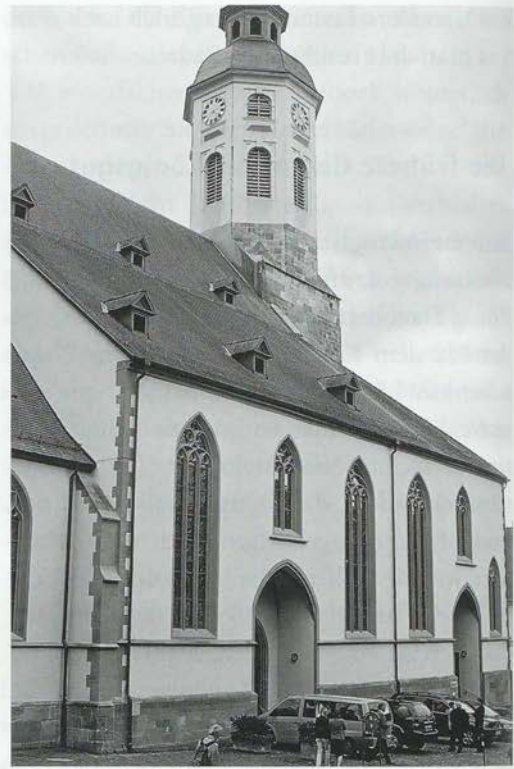
Stiftskirche von Norden. Das Untergeschoss des Westturms stammt noch aus romanischer Zeit, das Seitenschiff ist aus dem 15. Jahrhundert.
