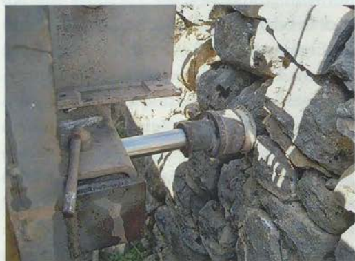
Beim SAL-Verfahren werden auskragende Steine mittels Hydraulikstempel zurückgedrückt.
