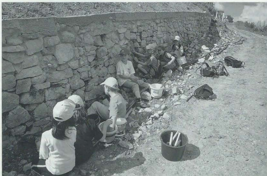
Kinder beim Einbringen von Sedumsprossen in die offenen Fugen eines sanierten Mauerabschnitts.
