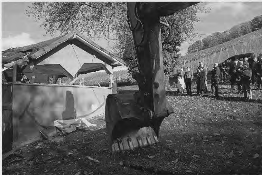
Leuchtturmprojekt »Käfersberg«. Abriss des alten Gebäudes
