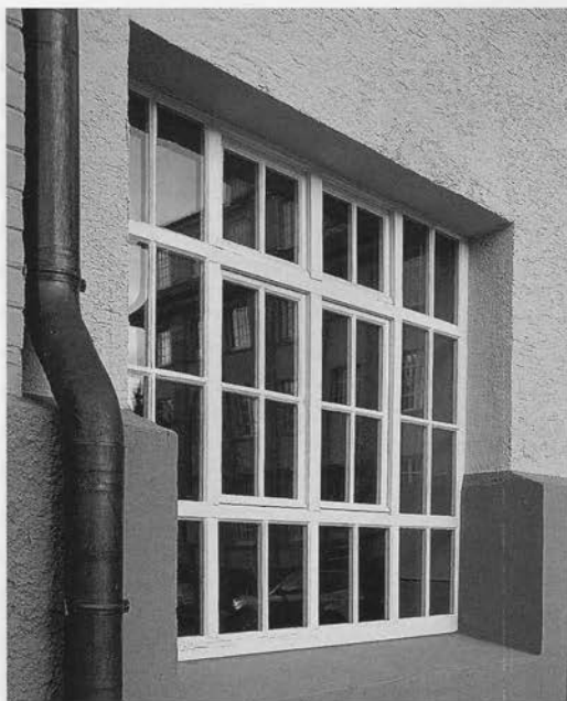
Die mustergültig restaurierten »Panzerfenster« von 1921 mit ihrer doppelten Verglasung, eine Besonderheit des ehemaligen Hohner-Baues.
