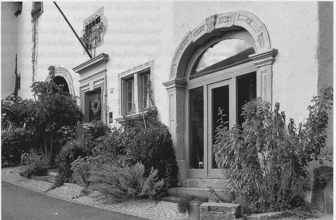
In der Außenmauer des Hauptbaus zeugen Gewände aus Renaissance und Barock von einer wechselvollen Baugeschichte des Oberen Schlosses.
