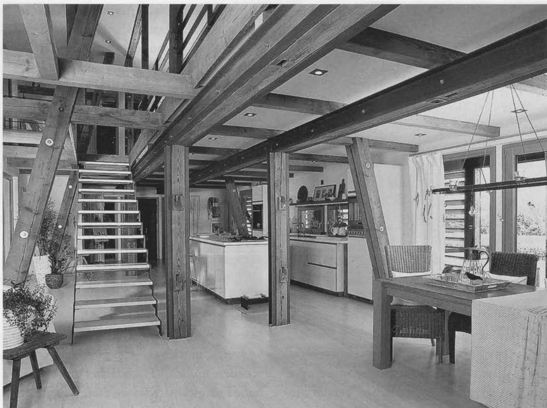
Blick in die Wohnung von Carola und Florian Blümig: Das Holzskelett der Konstruktion bestimmt auch hier den Raumeindruck.
