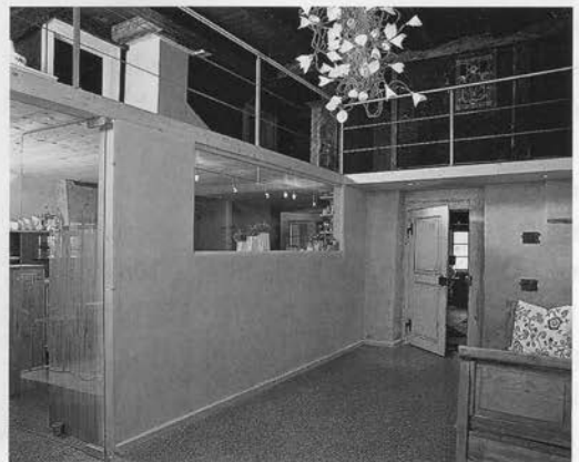
Alt und Neu im Franz-Seppe-Hof: der Einbau der modernen Küche in die wieder freigelegte, durch beide Stockwerke reichende Rauchschieberküche von 60 qm.
