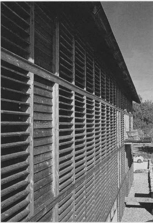
Die charakteristische Außenhaut des Tabakschuppens mit ihren verstellbaren Lamellen nach der Erneuerung.
