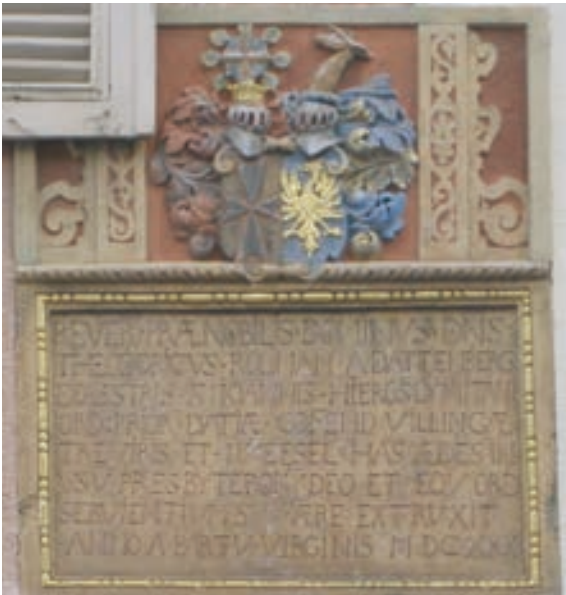
Bild 14 (links): Am Haus, Gerberstraße 15.
