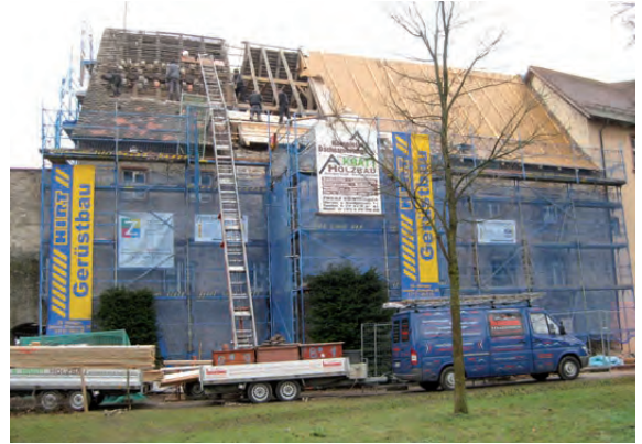
Abb. 19: Blick auf die Nordfassade während der Bauarbeiten.
