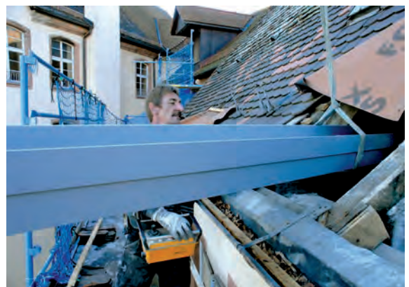
Abb. 9: Einbringen der Stahlträger über den Dachstuhl.
