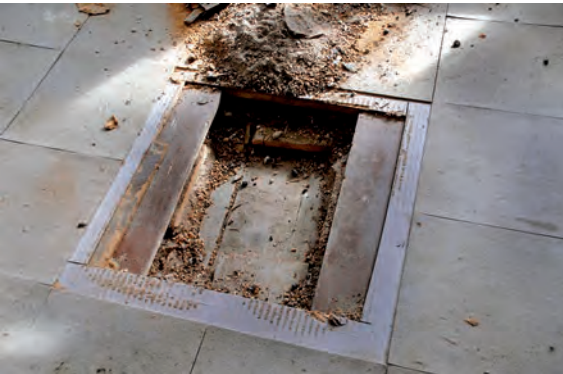
Abb. 11: Raum 2.01: Sondageöffnung im Bodenbelag.
