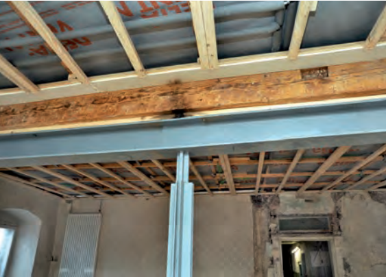
Abb. 10: Stahlträger im Saal und die sichtbaren Spuren der vor Ort zusammengeschweißten Trägerelemente.
