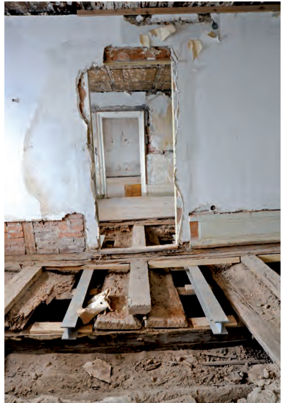
Abb. 3: Durchblick durch die freigelegten, südlich gelegenen Räume im 2. Obergeschoss.
