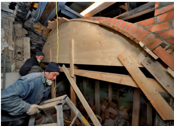
Abb. 15: Restaurierung und Nachbau des Gewölbes.
