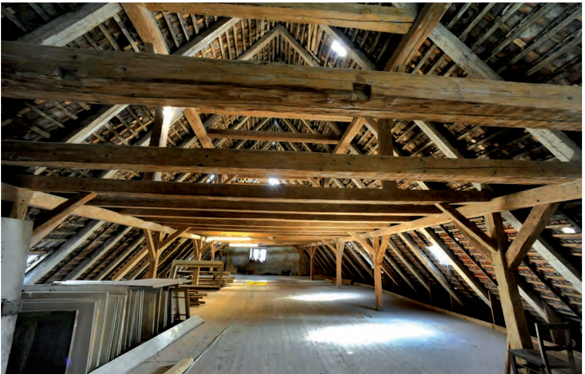
Abb. 18: Dachstuhl während der Sanierung.
