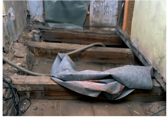
Abb. 12: Flurbereich im 2. Obergeschoss: Entkernung des Fußbodens.
