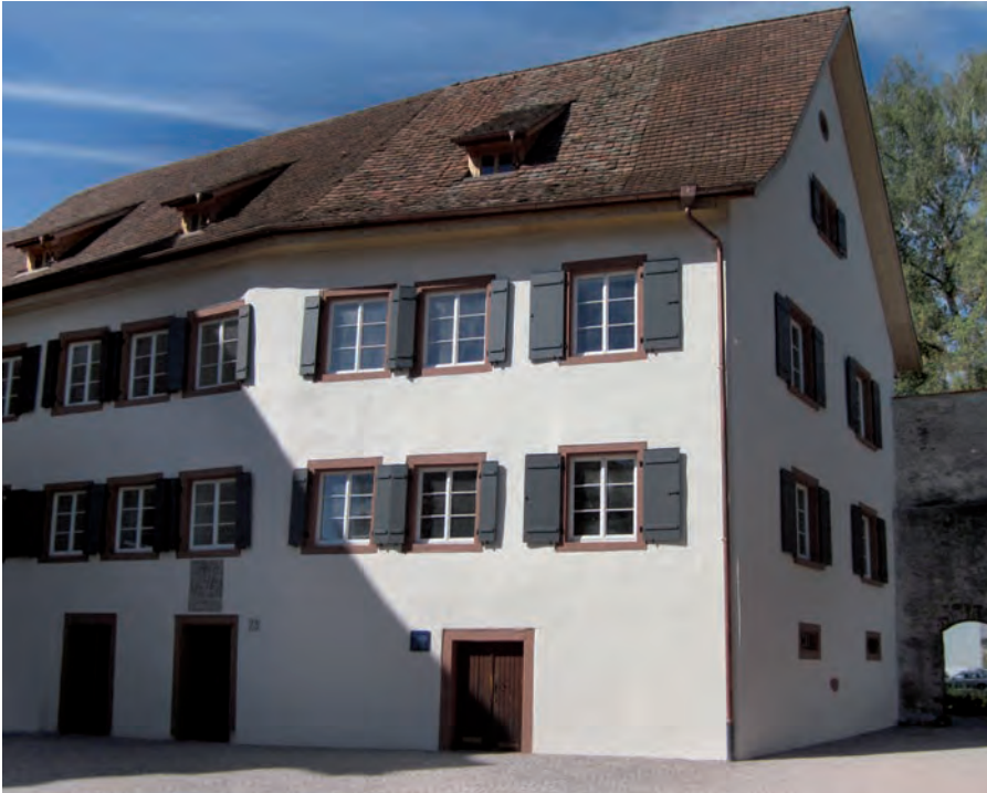
Abb. 20: Ansicht der neuen Süd- fassade nach der Sanierung.
