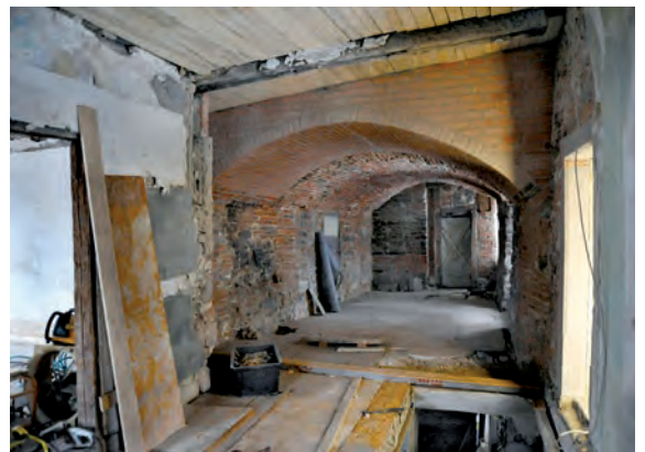
Abb. 16: Blick durch den neuen Teil des Gewölbes (vorne) auf den freigelegten Durchgang und das entkernte Treppenhaus.
