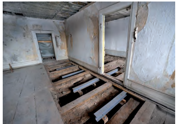
Abb. 8: Verstärkung der Böden durch Stahlträger.
