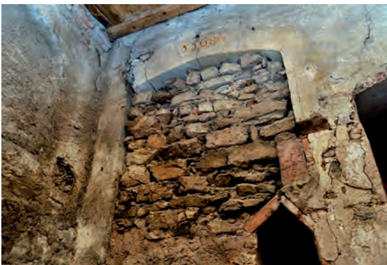
Abb. 1: Umbaumaßnahmen im Lauf der Zeit: Blick auf den im Jahre 1568 zwischen Alt- und Anbau ausgebrochenen Durchgang im Keller des Gebäudes.
