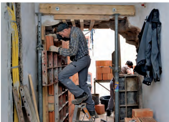
Abb. 7: Durchbruch der Außenmauer für den neuen Anbau des Fahrstuhls.
