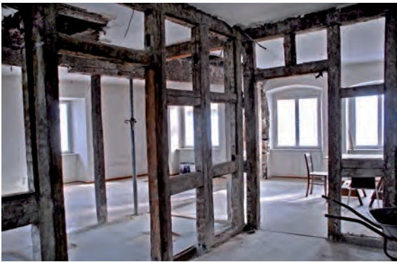
Abb. 5: Blick in den jetzigen Saal vor der Entkernung aller Räume in diesem Bereich.
