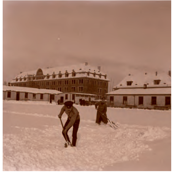
Abbildung 3: Blick von Süden auf die Gebäude des Wachpersonals. Im Hintergrund die neuen Kasernengebäude. Quelle: ICM/Netherlands.
