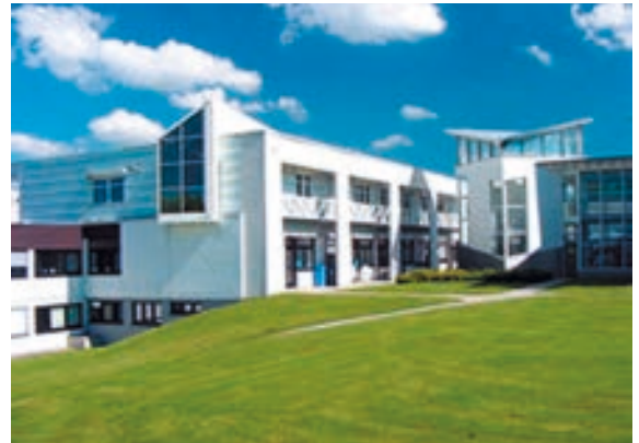
Abb. 3: Nephrologisches Zentrum Villingen-Schwenningen mit Ärztehaus am alten Standort Schramberger Straße, Schweningen.
