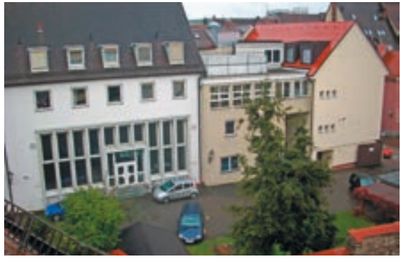
Abb. 9: Hier entsteht eine Galerie auf der Nordseite.
