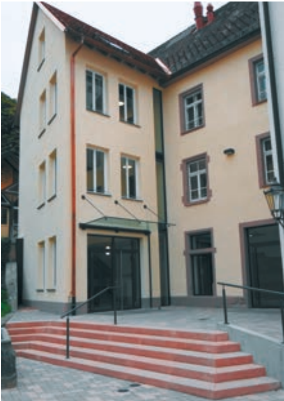
Abb. 7: Das neue Treppenhaus auf der Nordseite.
