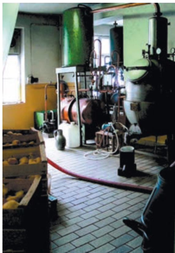
Abb. 9: Brennblase im Produktionsgebäude.
