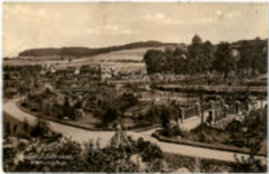
Abb. 13: Friedhofsanlage (SAVS 1.42.91 Nr. 199).
