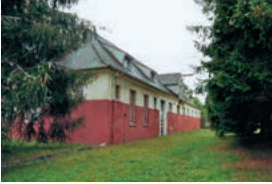
Abb. 15: Pontarlierstraße 1, Krankenstall der Kaserne.
