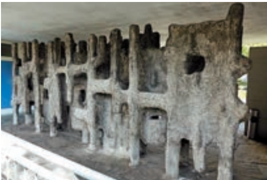
Abb. 21: Räumliche Wand am ehemaligen Finanzamt Schwenninger Straße von Otto Hajek.
