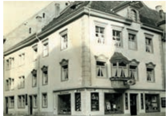
Abb. 2: „Optische Centrale Singer“ nach dem Umbau in den 1920er Jahren Das Ladengeschäft in der Oberen Straße 15 und die Fabrikation in der Kanzleigasse 2/1.
