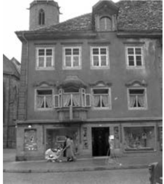
Abb. 11: Das Geschäftshaus in der Oberen Straße 15 kurz vor dem Abbruch im Jahre 1960.
