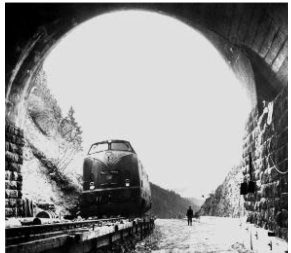
Abb. 3 „Verbautes“ Gleis in ursprünglicher Höhe, rechts im Bild ist die nach unten verlängerte Tunnelwand mit Felsanker zu sehen, die Tunnelsohle ist hier um 50 cm gegenüber dem noch vorhandenen Gleis abgesenkt.
