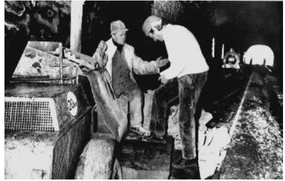
Abb. 5 Mischmaschine für die Zementinjektionen.
