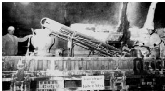
Abb. 4 Abdichtungsarbeiten an den Tunnelgewölben.
