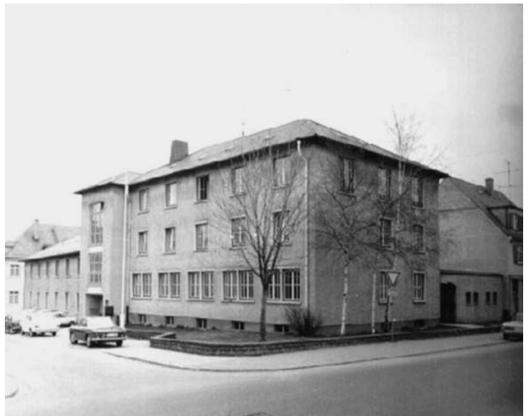
Im Jahr 1955 wurde ein zweiter Neubau in der Uhlandstraße (heute Justinus-Kerner-Straße) bezogen.
