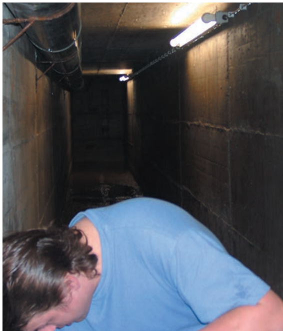
Im Schacht mit Blick zum Schachteingang.
