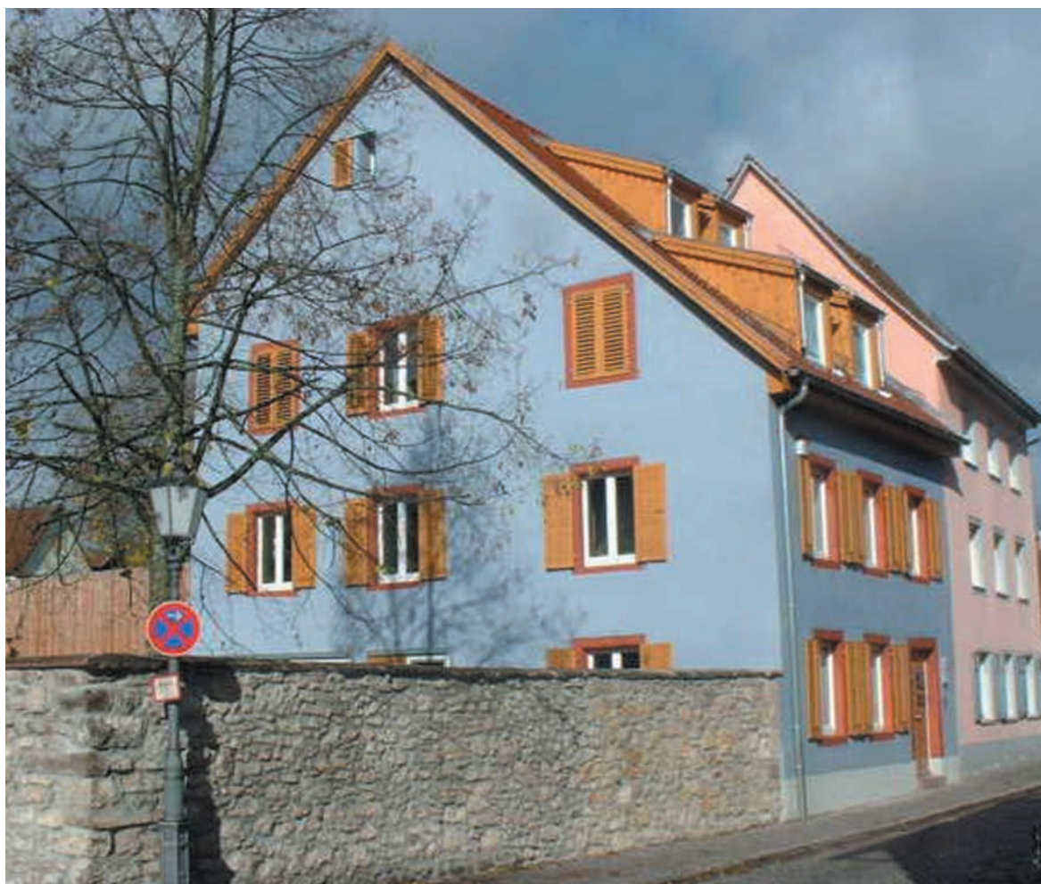
Haus Zinsergasse 12 nach dem Umbau.
