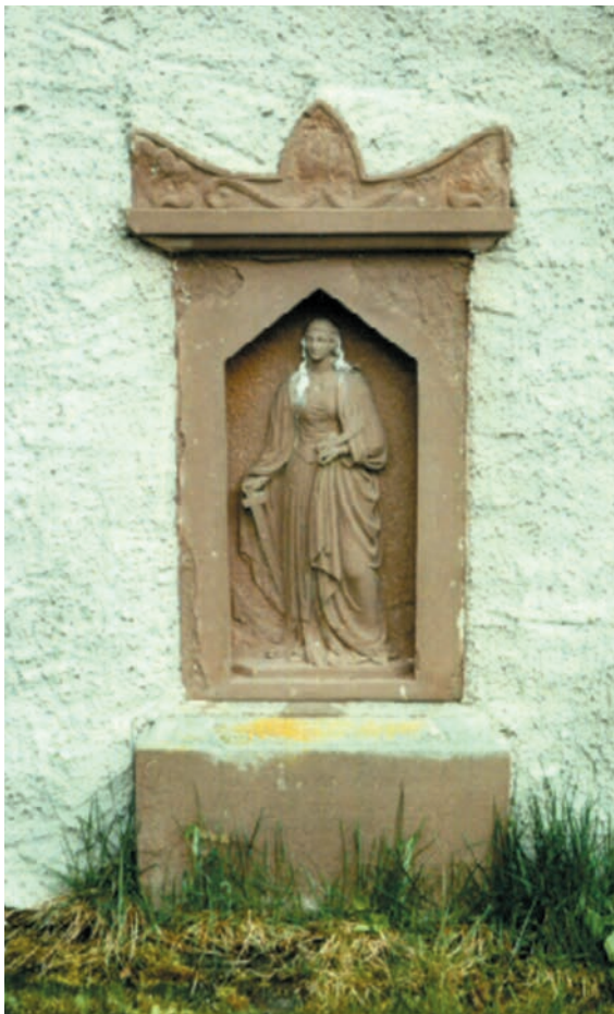
Abb. 1: Zustand vor der Restaurierung.
