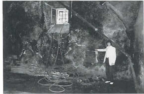
vor direktem feindlichen Artilleriebeschuss. Der Gesamtkomplex besitzt eine Kellerfläche von nahezu 250 qm. Die Decke wird von einem unterteilten Kreuzgewölbe gebildet; Höhenabstand 3,30 bis 4,45 m. In diesen Räumen haben wir allein im Dreißigjährigen Krieg die Lagerung von rd. 20 größeren und rd. 20 leichteren Geschützen und zahlreichem anderen Kriegsgerät (Vgl. Revellio, Beiträge ... , S. 362) anzunehmen. (Fotos Juli 1982)
