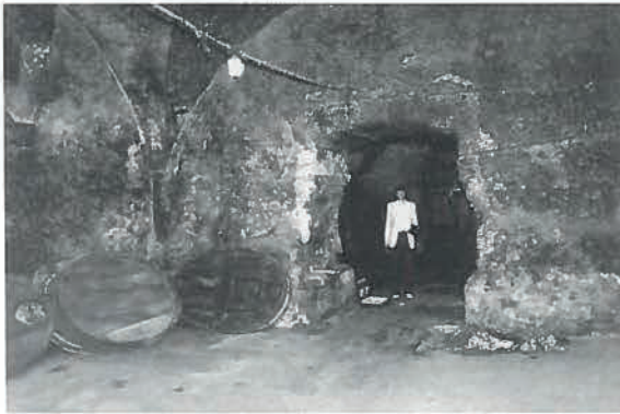
Hausinterne Kellerabtiefungen dieser Dimension, wie hier im ausgebauten öffentlichen, d. h. städtischen Zeughaus, dem ehemaligen Komplex der mittelalterlichen Kürnegger/Vetterversammlung, westlich des Oberen Tores, finden sich im Alten Villingen nur ganz selten. Die überwiegend mit Buntsandsteinplatten belegte Bodenfläche liegt annähernd 1,6 bis 1,8 m unter historischem Höhengelände, knapp über dem Grundwasserspiegel. Diese Abtiefung schützt
