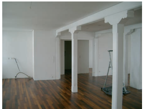
Die fertige Einheit mit Unterzügen und Stützenreihe
