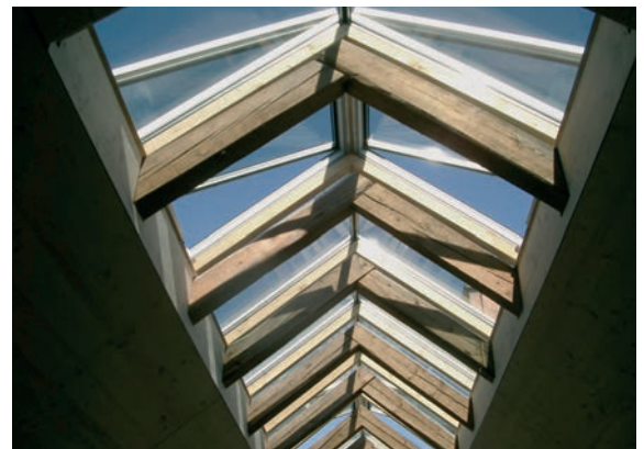
Oberlicht im Dachgeschoss; die bestehende Tragkonstruktion wurde belassen.
