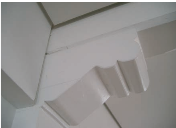
Die restaurierten Sattelhölzer
