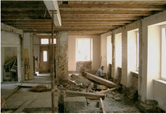
Das entkernte Erdgeschoss
