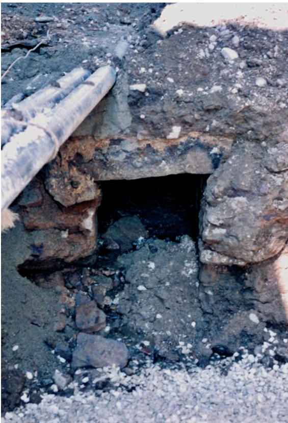
Ein starker „Steindeckel“ bildet die Decke des im lichten Maß 60x 90 cm betragenen Querschnitts des Kanals.
