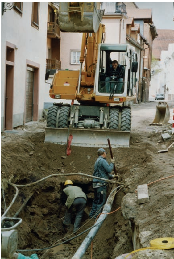
Das alte Kanalsystem des 19. Jahrhunderts in der Innenstadt wird ergraben, beseitigt und durch Röhren ersetzt. Hier: Webergasse, Mai 2006
