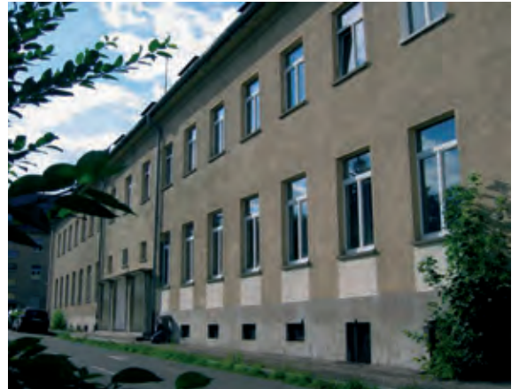
Das Wirtschaftsgebäude, das entlang der Kirnacher Straße steht – vom Innenhof her aufgenommen.
