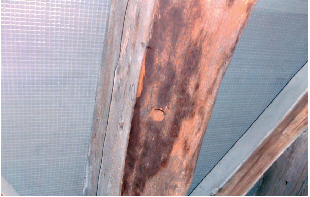
Münster-Dachstuhl West. Bohrloch der Holzkern-Probenentnahme zur Bestimmung des Fällungsjahres (Winter 1398/99).
