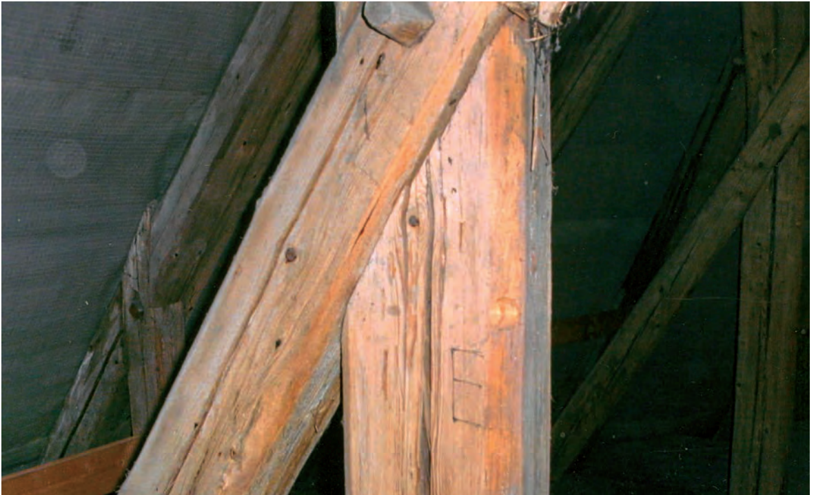
Münster, Chor. Stützbalken mit Bohrloch der Holzkern-Probenentnahme. Fällungsjahr (Winter) 1456/57.
