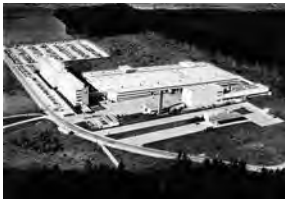
Abb. 12: Werk Sommertshäuser Halde (StAVS).
