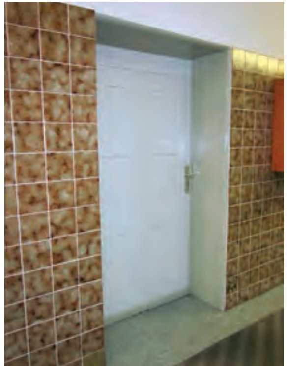
Abb. 8: Historisches Türelement vor dem Umbau.
