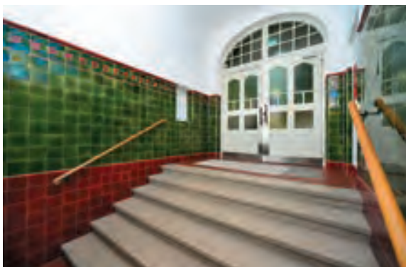
Abb. 15: Windfang nach der Sanierung.
