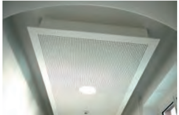
Abb. 12: Abgehängte Deckensegel im Flurbereich mit sichtbar gelassener historischer Decke mit Rundungen im Bereich des Wandübergangs zur Decke.
