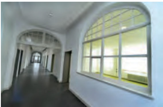
Abb. 11: Bestandsfenster im Flur im 1.OG.
