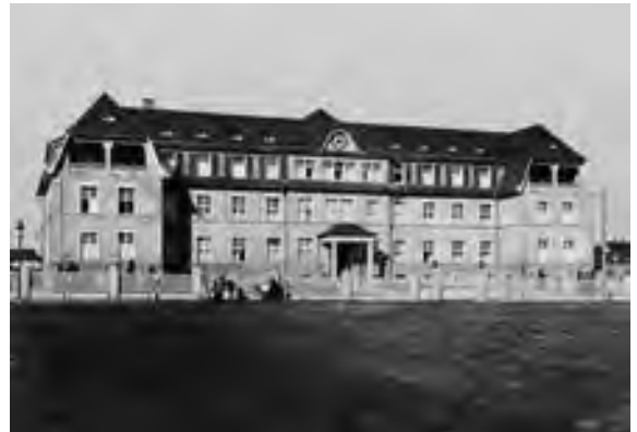
Abb. 1: Neubau Friedrichskrankenhaus um 1915.
