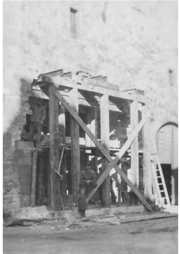
Foto von 1937 bei den Tordurchbrucharbeiten.
