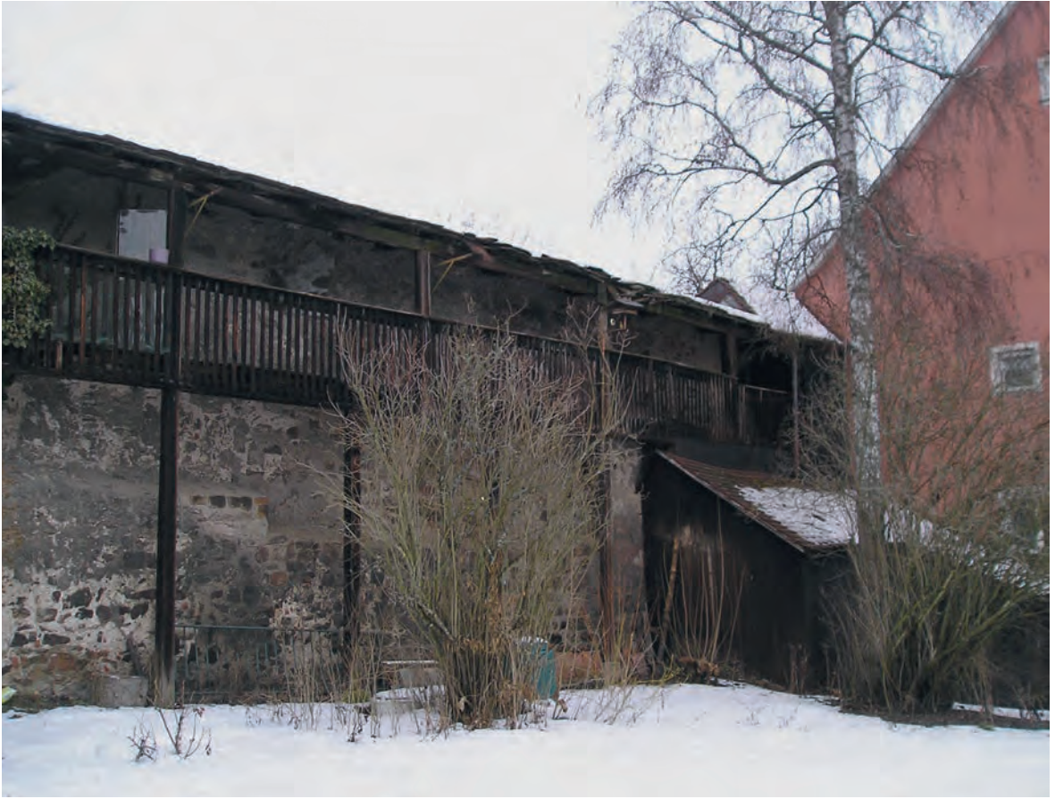
Abb. 3: Absatz an der inneren Stadtmauer weist, wie im Bereich des Käferbergles, auf einen ehemaligen Wehrgang hin.
