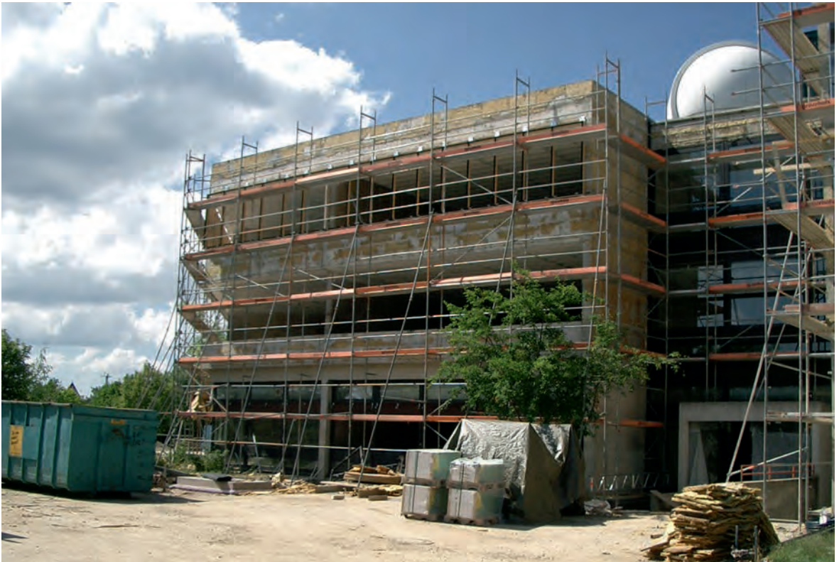
Die Südseite im Umbau.
