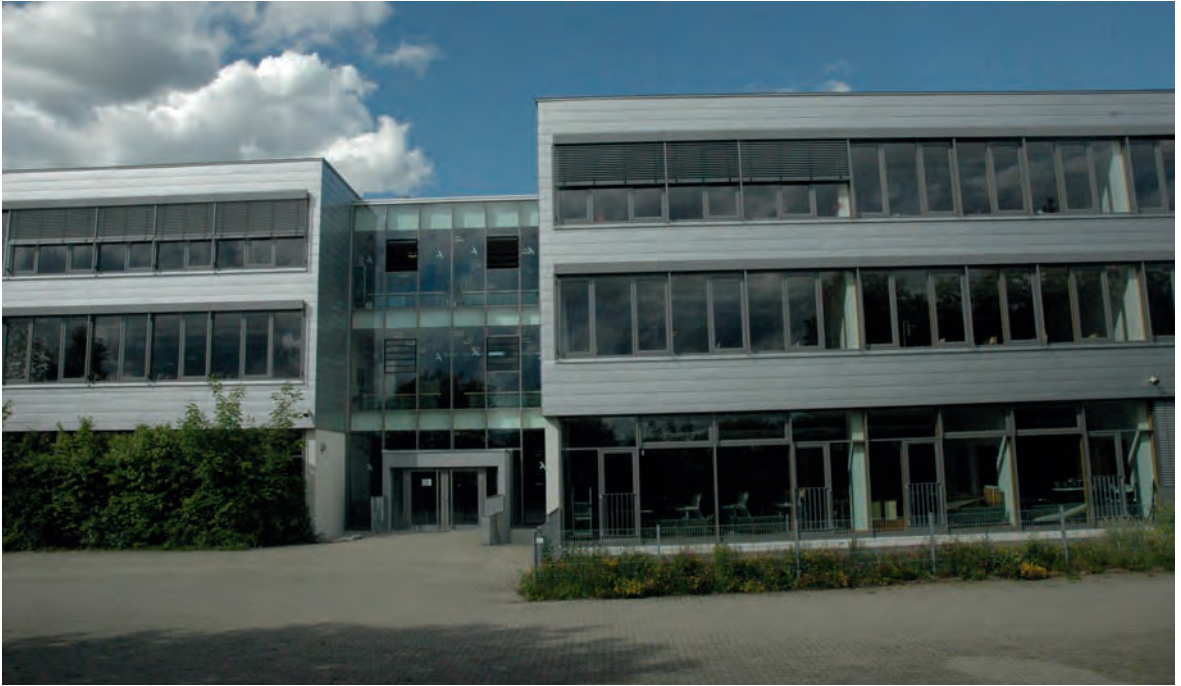
Die wiederbergestellte Südseite.
