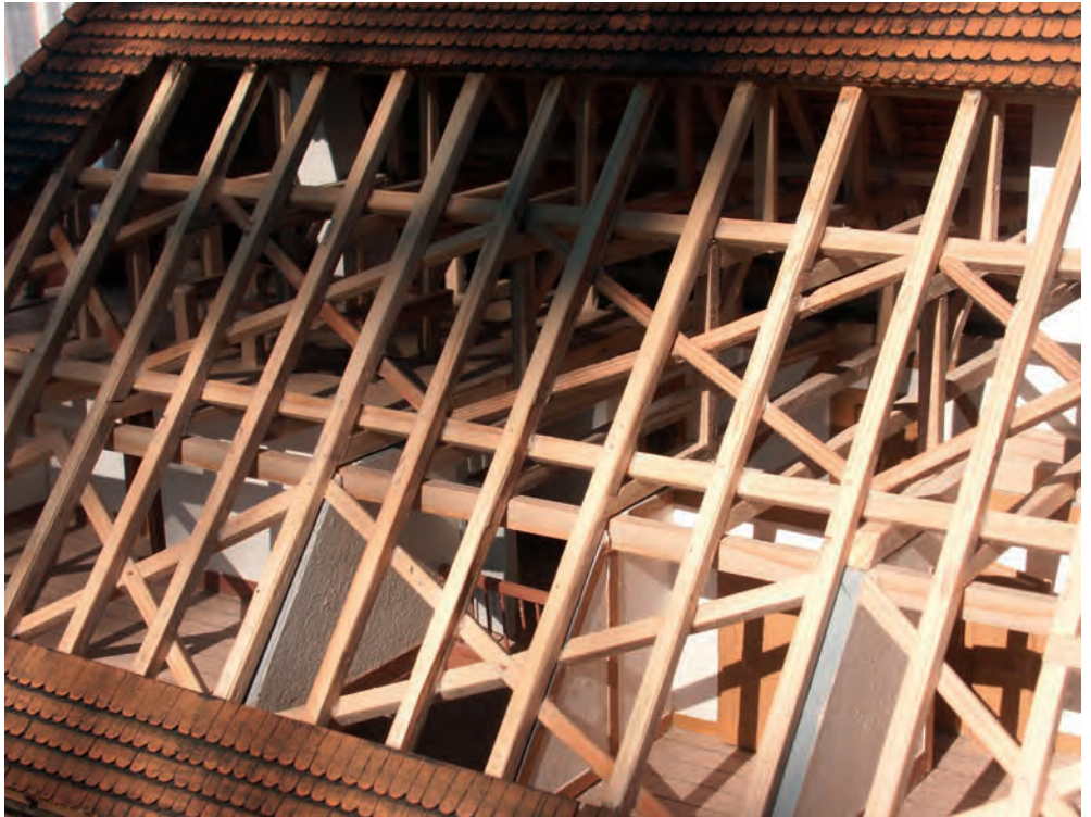
Abb. 3: Keine einfache Bastelarbeit: Der Dachstuhl des Gutleuthauses im Maßstab 1:50.
