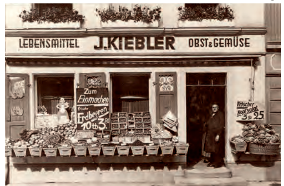
Abb. 2: 1931 blickt Johann Kiebler, nach dem Rechten auf der Niederen Straße
